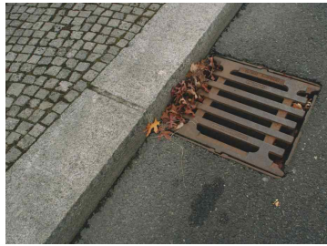
배수구, 하수관거 등 배수시설 점검
